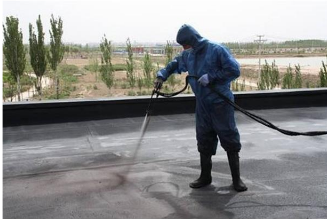
Spray asphalt primer
